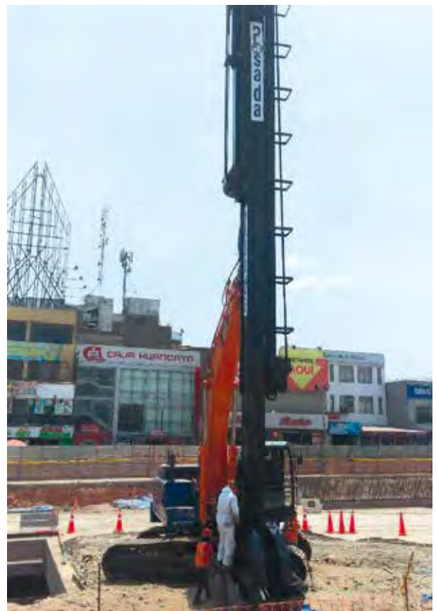
Excavadora de 50 Tn con Teledipper de 28 metros - Posada Perú
