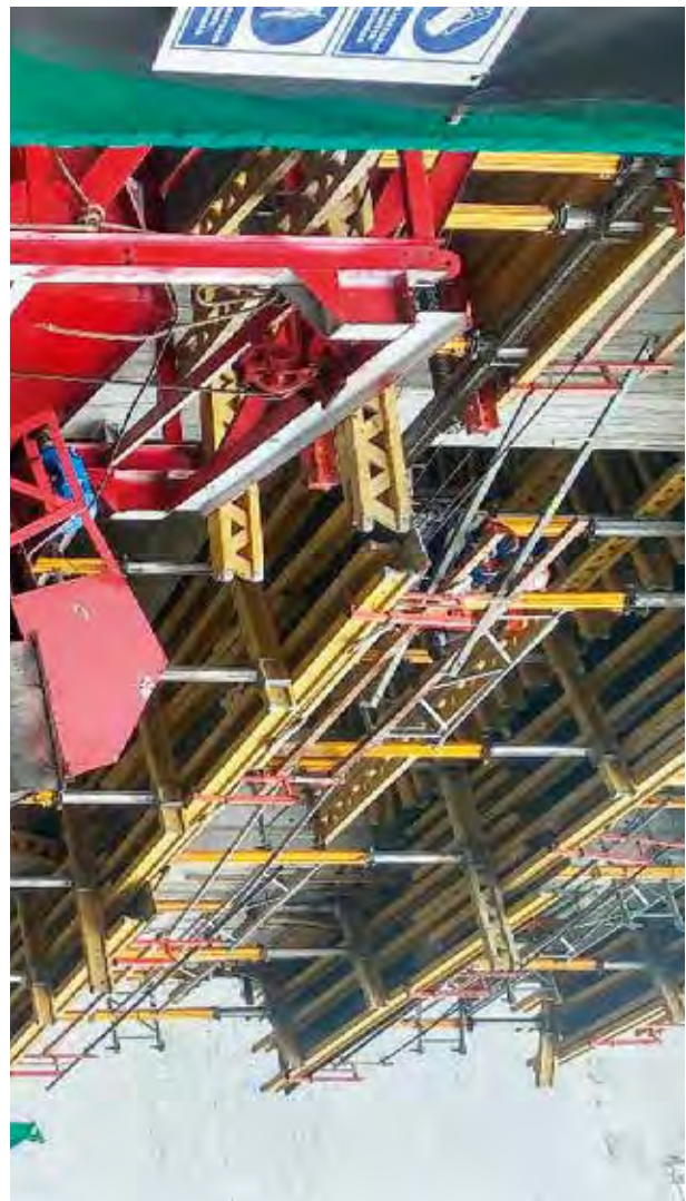
Equipo de izaje instalado en edificio Primera Visión en Magdalena del Mar - Posada Perú
