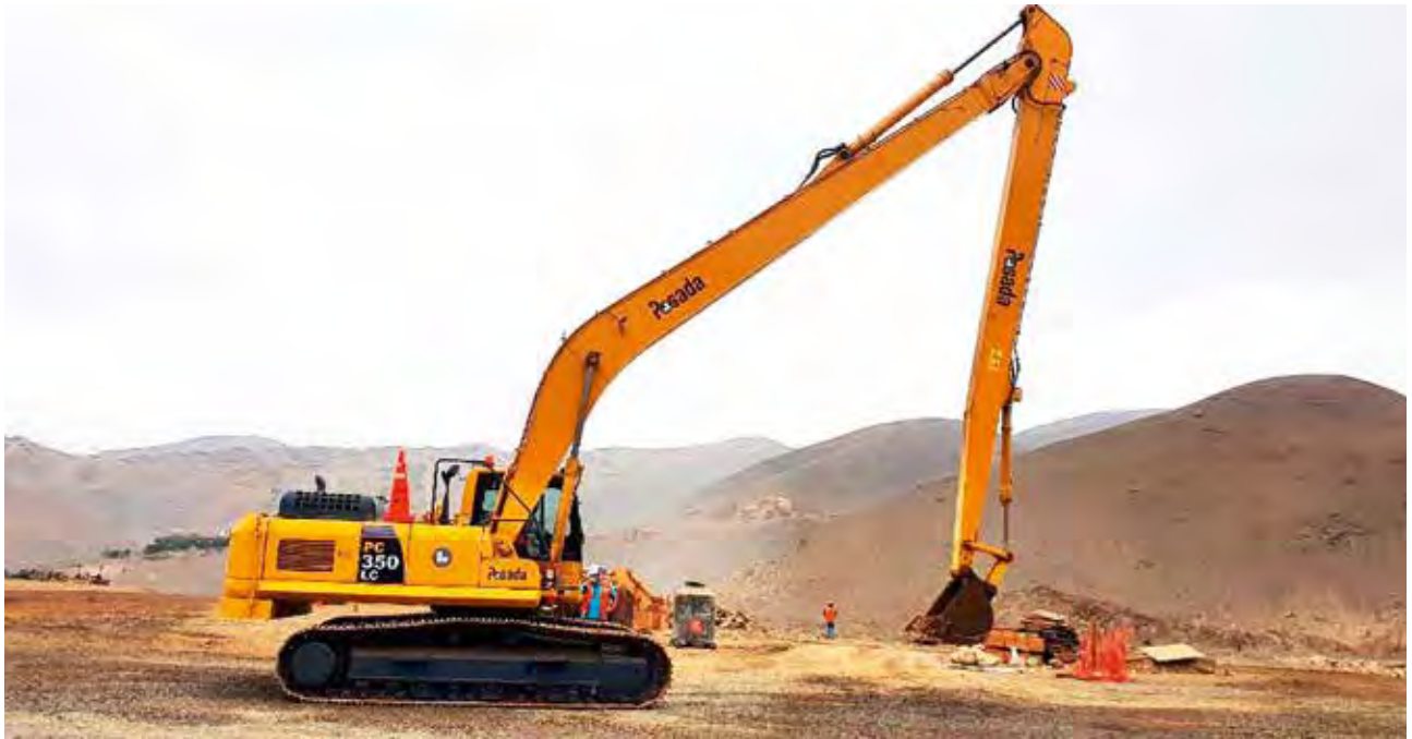
Excavadora con brazo largo de excavación de 20 metros - Posada Perú
